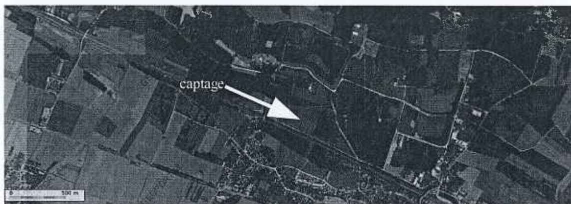
Illustration 4: vue aérienne du site du captage de Villeneuve La Guyard
